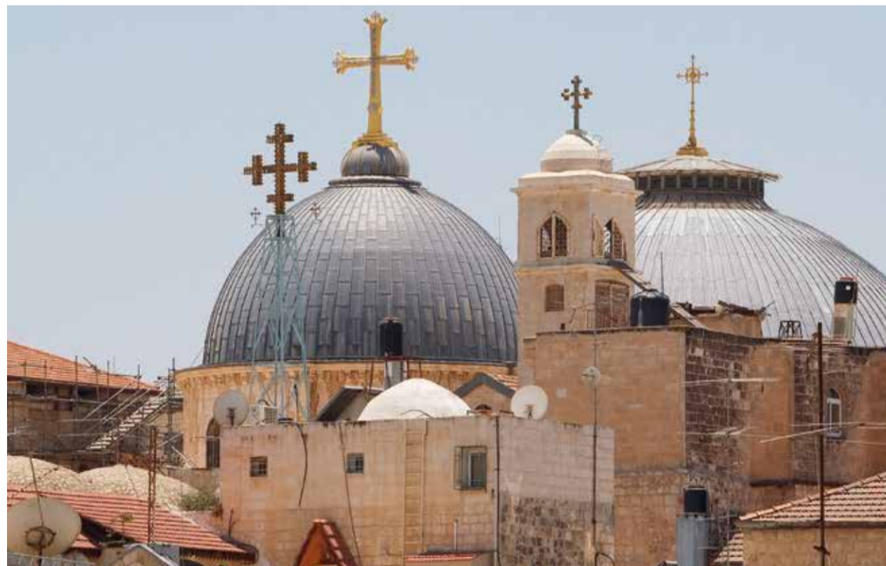
Kirchendächer in der Altstadt von Jerusalem. In Israel begehen Juden ihren Ruhetag am Samstag, Christen am Sonntag und Muslime am Freitag. Foto: Canva
