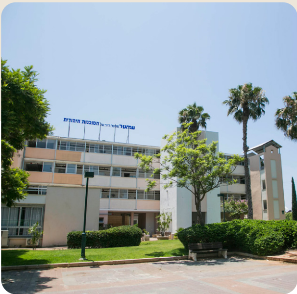
Das Amigour-Wohnheim in Ashkelon hat bereits vor zwölf Jahren einen Schutzturm erhalten, im Bild erkennbar an der weißen Außenfarbe.
